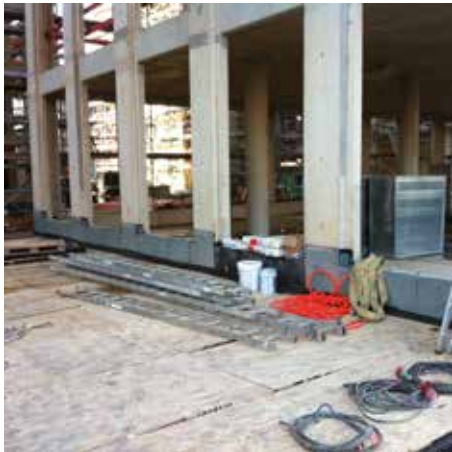
Lochfassade mit raumhohen Fenstern: Keine nennenswerten Deckenrandverformungen.
